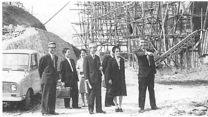
本館建設工事現場視察 (S.39.12.9)
