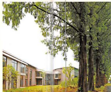
講義棟(新講義棟) 外殻のコンクリート造りの中に木造を入れる「入れ子構造」。建物の耐久性を高めながら、木造の温かさと陽光の明るさが調和した空間をつくり出している。
